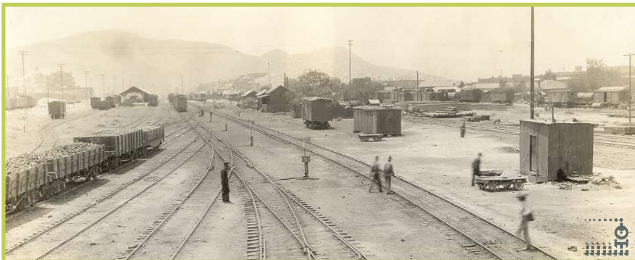
Un detalle de vías en el patio del Ferrocarril Central en Torreón. Vista al norte. Fondo Comisión de Avalúo e Inventarios. CNPPCF, CEDIF, Fototeca.
