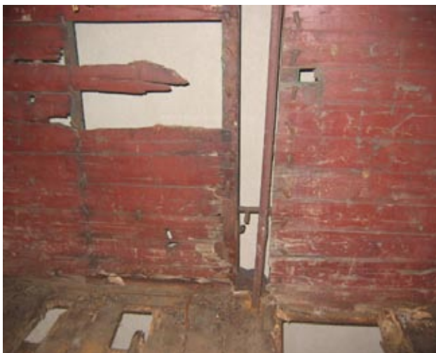
Faltantes en el interior del furgón.
