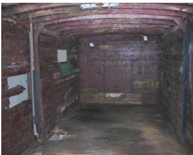
Vista del interior : al fondo se ven aperturas de ventilación u observación cortadas a mano, de manera irregular.
