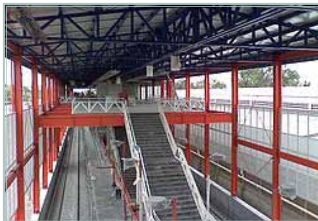
Interior de la estación Fortuna del sistema 1 durante su construcción (2 de enero de 2008).
