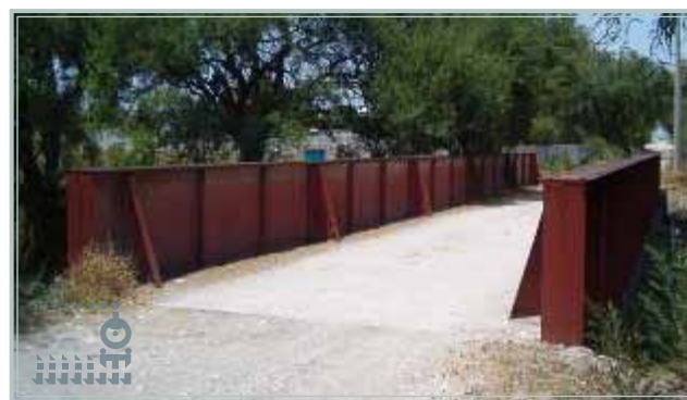
Puente de Tepeyahualco construido en 1910 y remodelado en 1957. 15
