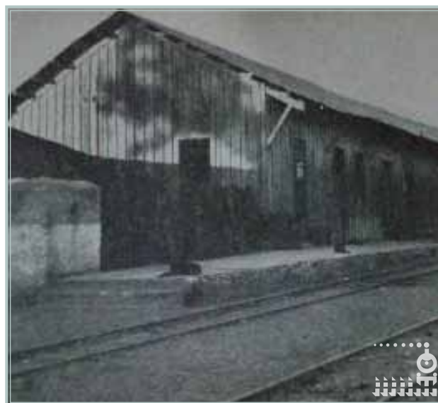
Bodega de madera y lámina de la estación Progreso de Ixcaquixtla. 24
