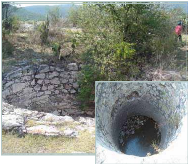
Toma de agua en Barranca Honda, construida en 1902. 23
