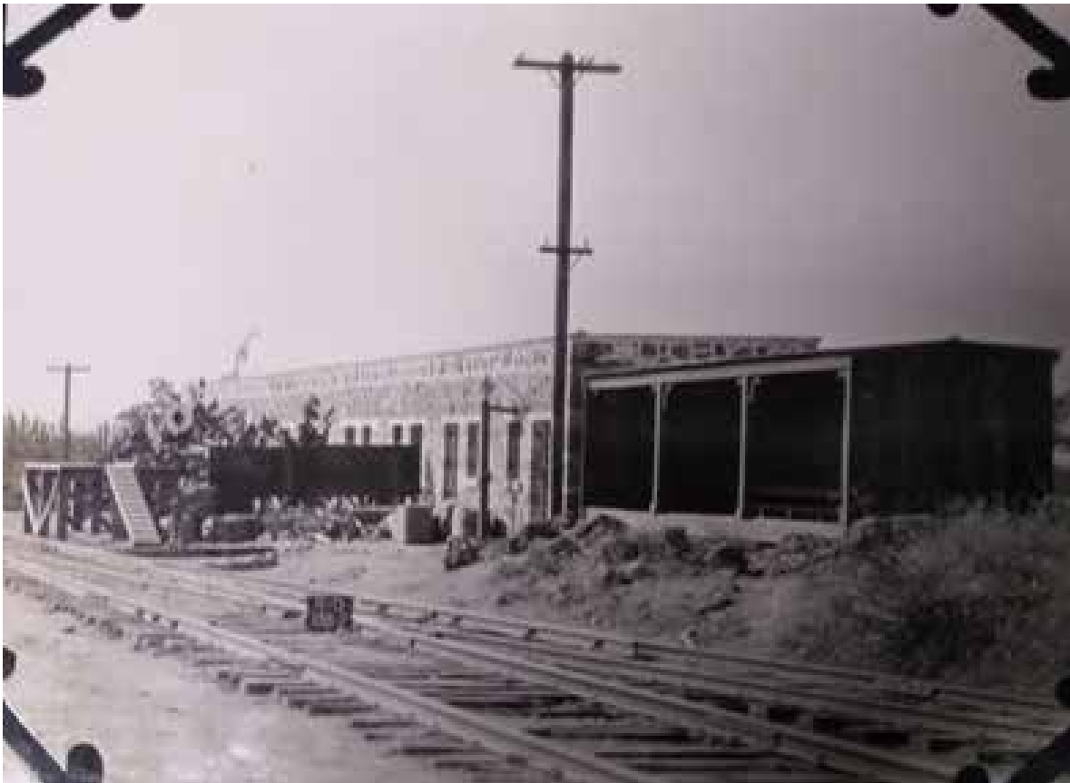
Estación de San Vicente, del México, Cuernavaca y Pacífico 22
