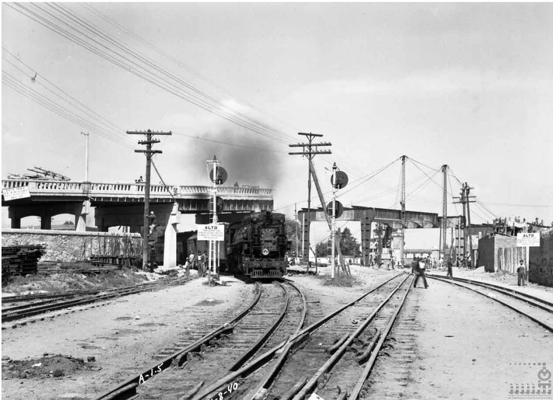
Detalle de las vías del patio de Buenavista, abajo del paso elevado en construcción por el Departamento del Distrito Federal, 8 de noviembre de 1940. Fondo FNM, Sección Comisión de Avalúo e Inventarios. CEDIF, CNPPCF, Secretaría de Cultura.
